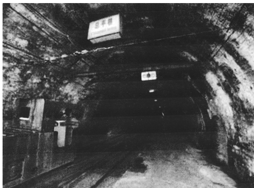
图 4-37 萍矿总平巷内景
