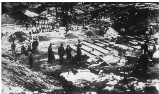
图 4-19 汉阳铁厂改扩建工程 3 号高炉现场
