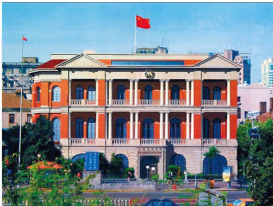
修缮后的上海外滩9号楼
