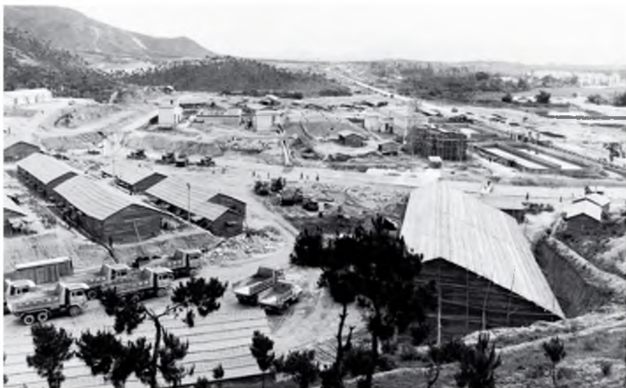
蛇口早期建设中的工地
