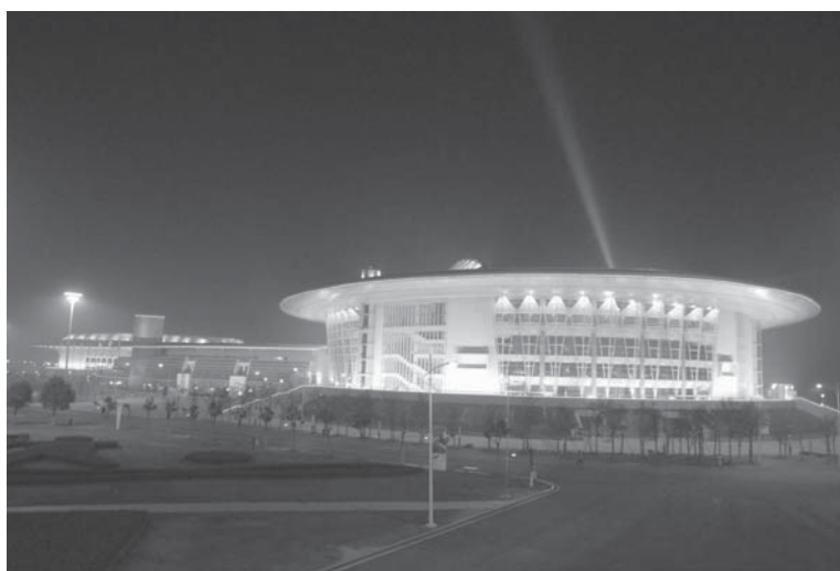
图 7-4 武汉体育中心体育馆（由招商局物业提供物业管理）
